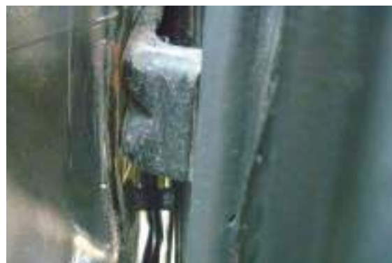
ピラーとドアヒンジの隙間
