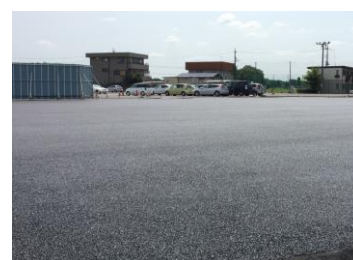
アスファルト舗装後の つくばヤード
